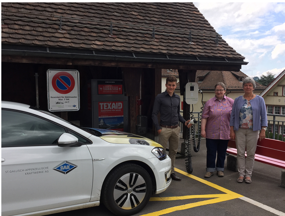
Freuen sich über die neu installierte Ladestation: Jan Müller, SAK Projektleiter Elektroinstallation, Gemeinderätin Daniela Heyer und Gemeindepräsidentin Dorothea Altherr (v.l.n.r.).
