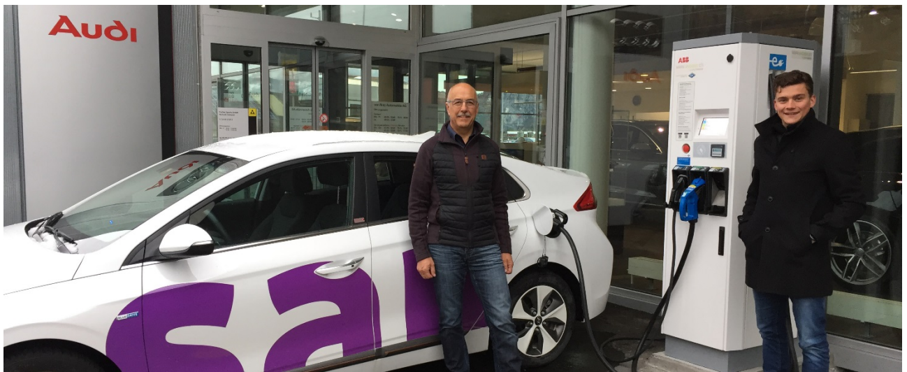
Freuen sich über die neu installierte Ladestation: Ernst Hännny, Geschäftsleiter der Von Roth Automobile AG in Bad Ragaz (links) und Jan Müller, Projektleiter Elektroinstallation der SAK.
