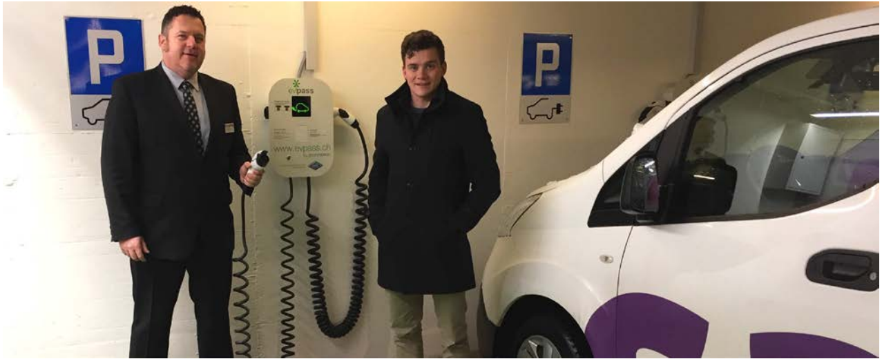
Freuen sich über die neu installierten Ladestationen: Centerleiter des Sântispark Abtwil Michael Gees (links) und Jan Müller, Projektleiter Elektroinstallation der SAK.
